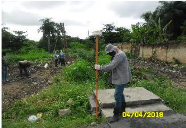
FOTO Nº 13 - LEVANTAMENTO TOPOGRÁFICO NA ÁREA DO CANAL ABERTO (BACIA 02)
