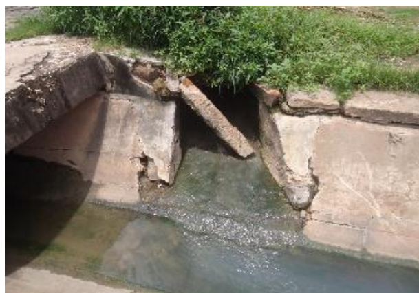
FOTO N° 02 - TRECHO DANIFICADO DA GALERIA EXISTENTE (BACIA 01)
