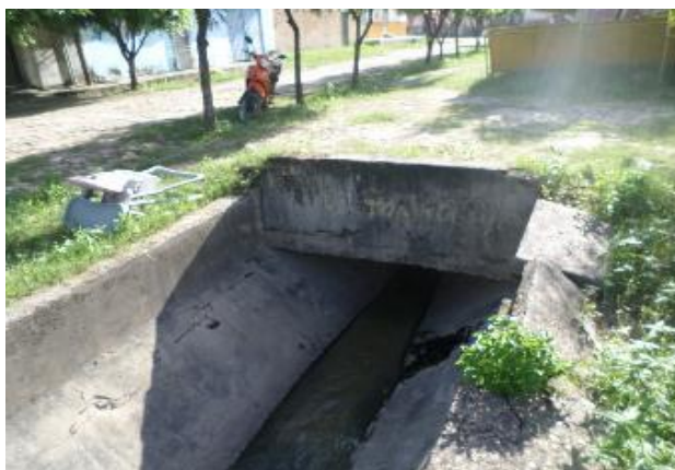
FOTO N° 05 - FINAL DA GALERIA EXISTENTE A CÉU ABERTO E O COMEÇO DA GALERIA FECHADA (BACIA 01)
