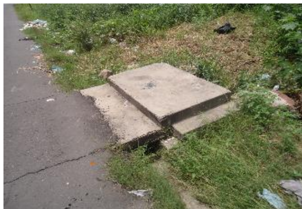
FOTO N° 04 - BUEIRO EXISTENTE EM UMA DAS RUAS PARA PASSAGEM DO CANAL (BACIA 02)
