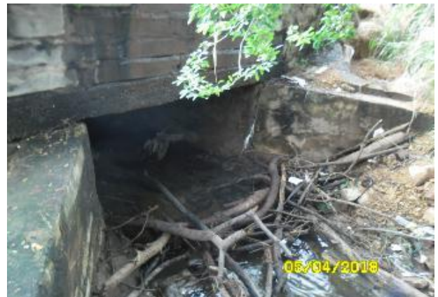
FOTO Nº 16 - FINAL DO CANAL EXISTENTE E O COMEÇO DA GALERIA FECHADA (BACIA 02)
